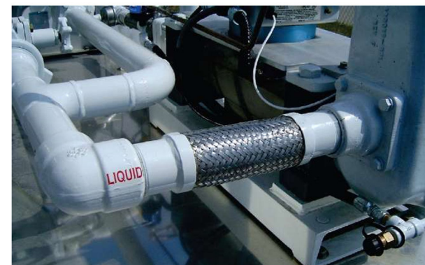
Рисунок 3 гибкий шланг во входном отверстии
